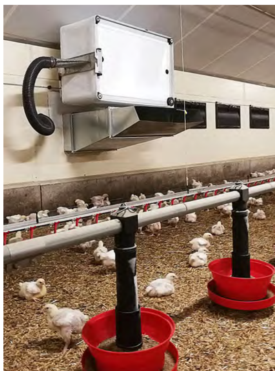
Figure 10 : Ce système permet de filtrer puis d'aspirer les poussières en bâtiments, avant extraction de l'air
